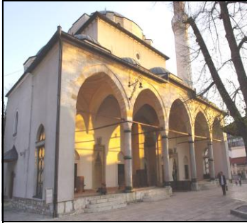
لوحة رقم (٨): واجهة السقيفة التي تتقدم جامع غازي خسرو بك في سراييفو باليوسنة. (الباحث).
